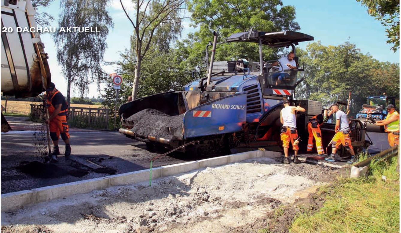
Schweißtreibende Arbeit auf der Schleißheimer Straße: Fahrbahnsanierung und Einbau eines lärmindernden Asphalts.
