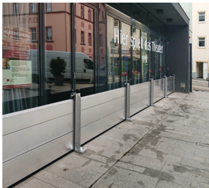
Objektschutz mit teilmobilen Schutzelementen
