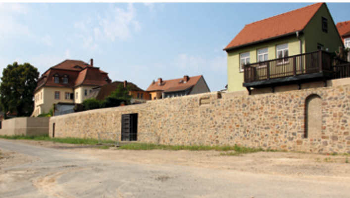
Integrierter Hochwasserschutz in der historischen Stadtmauer ...
