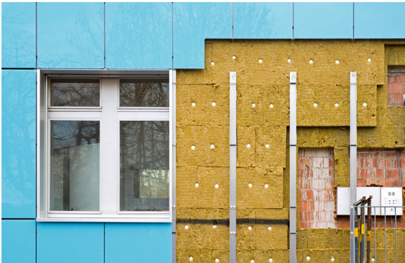
Hinterlüftete Fassadenkonstruktion
