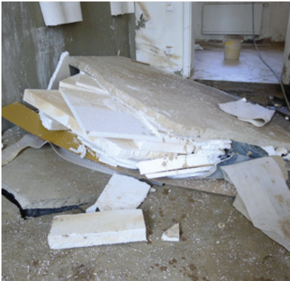
Aufgeschwommene Fußbodenkonstruktion
