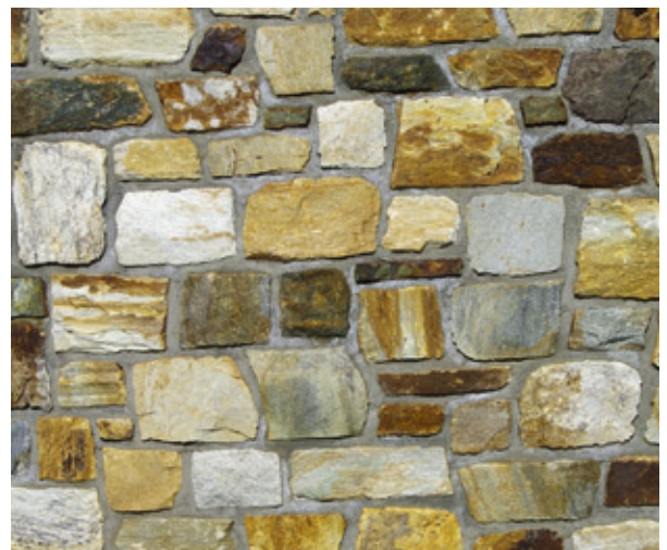
Unregelmäßiges Natursteinmauerwerk
