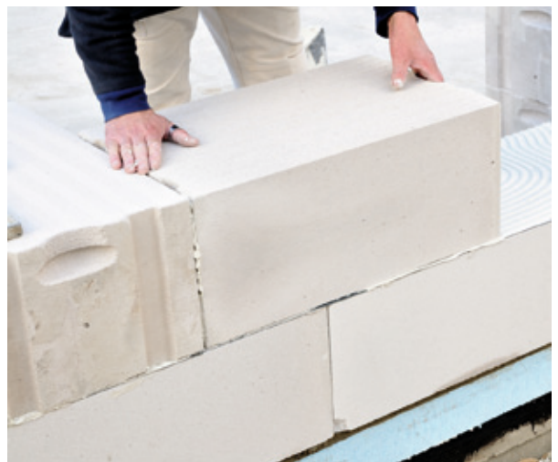
Mauerwerk aus Porenbeton-Plansteinen
