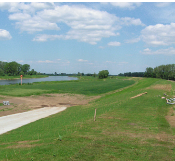
Sanierter Hochwasserschutzdeich an der Elbe
