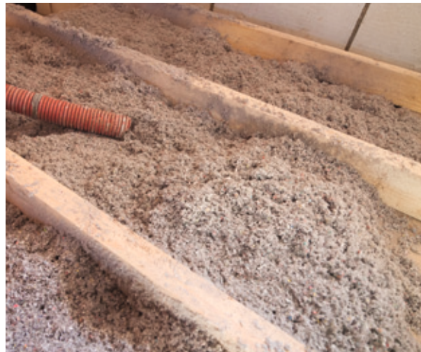
Anwendung von Zelluloseflocken im Fußbodenbereich
