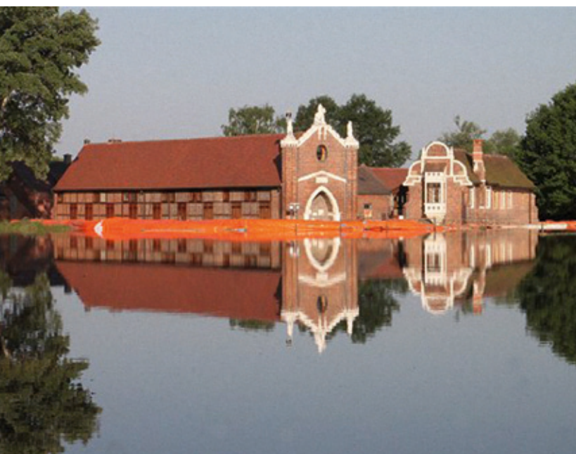
Objektschutz mit mobilem wassergefülltem Schlauchsystem
