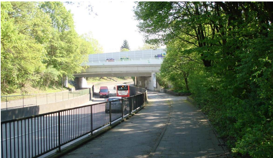
Abbildung 14 Erich-Ollenhauer-Straße, Blick nach Osten
