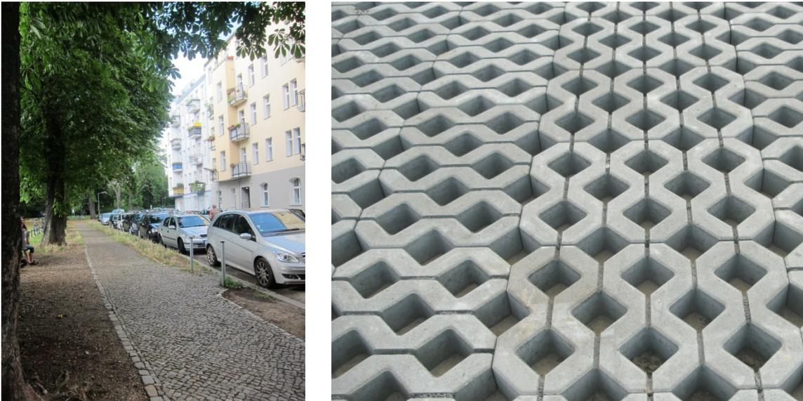
**Abbildung 19:** links: Versickerungsfähiger Fußweg (Foto: Miriam Lübbecke); rechts: Rasengittersteine (Foto: Mar-Tollas / pixelio.de).
