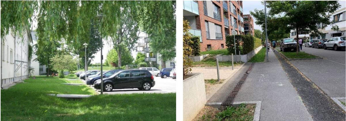
**Abbildung 26: Querungen von Ableitungs- und Versickerungsmulden mittels Stegplatten oder Kastenrinnen (Scharnhäuser Park, Ostfildern, RSD)**
