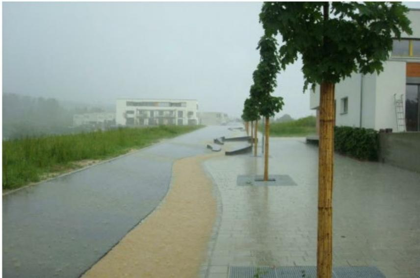
**Abbildung 31: Ableitung eines Starkregenereignis über eine Mittelrinne im V-Profil (Sonnensiedlung Esslingen-Egert, RSD)**
