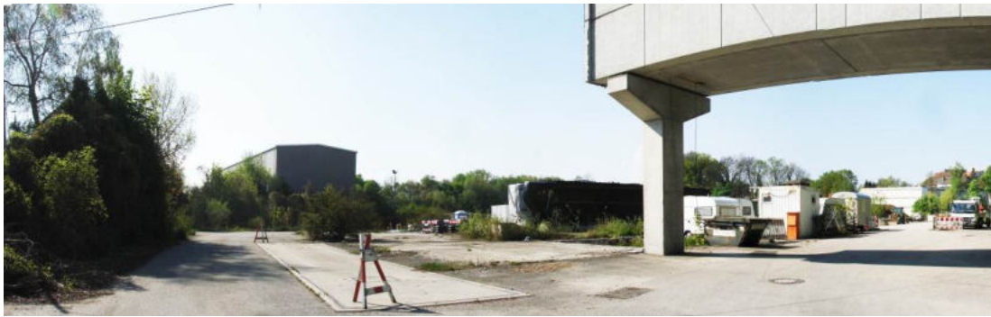
Abbildung 9 Holzlagerplatz von Norden (Aufnahme 2014)
