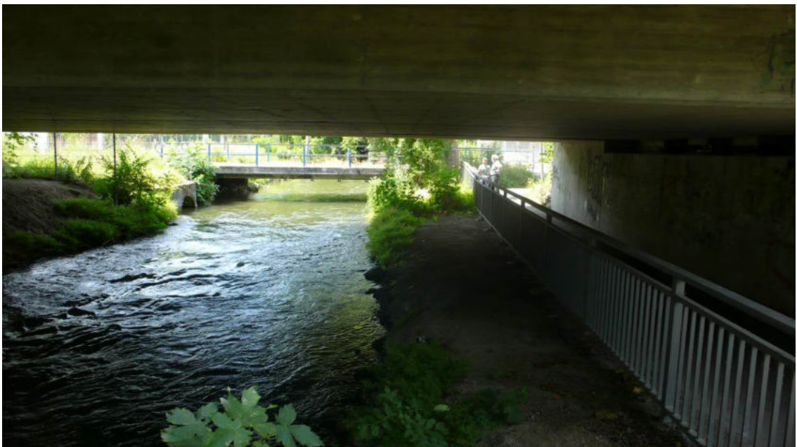
Abbildung 7 Mühlbach im Bereich der Unterquerung der Fernbahn
