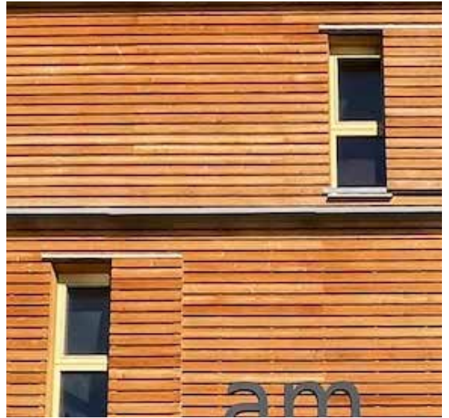
Abb. C.4.2 Gebäude mit Holzfassade und Holzschiebeläden
