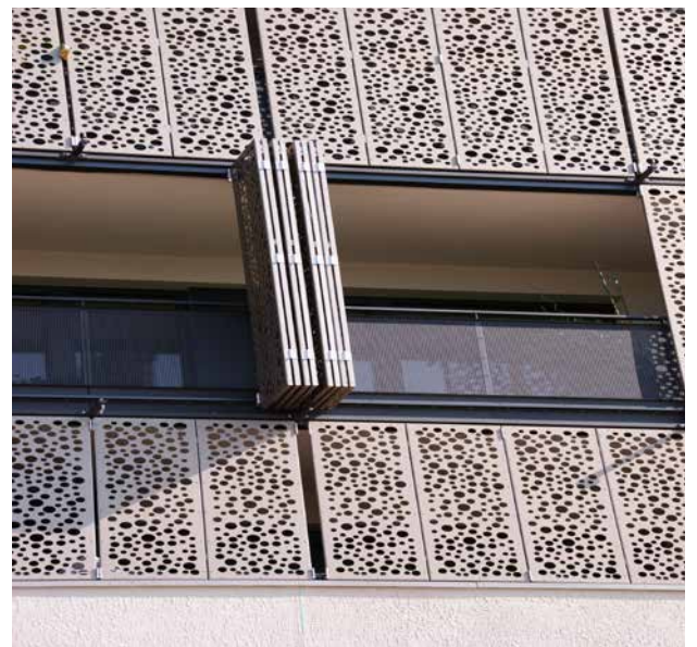
Abb. C.8.2 Loggia mit halbtransparenten Fassadenelementen
