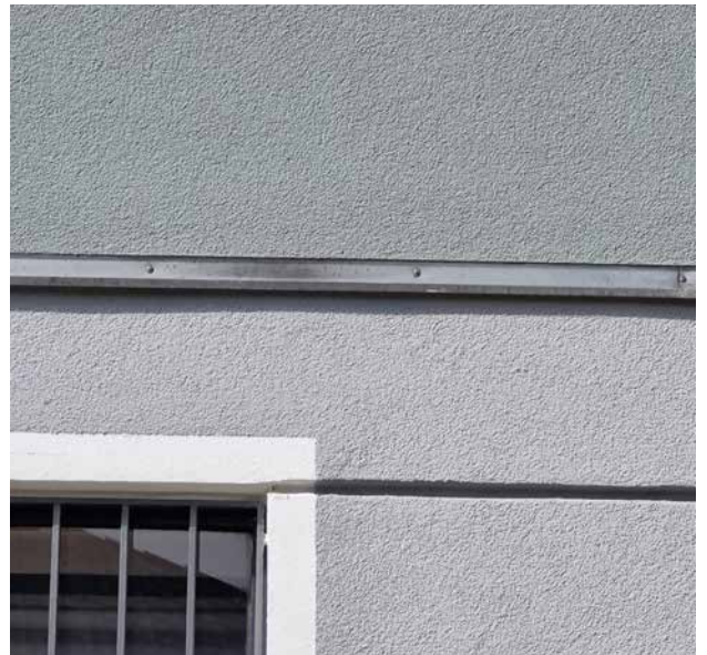
Abb. C.4.3 Hochwertig gestaltete Putzfassade
