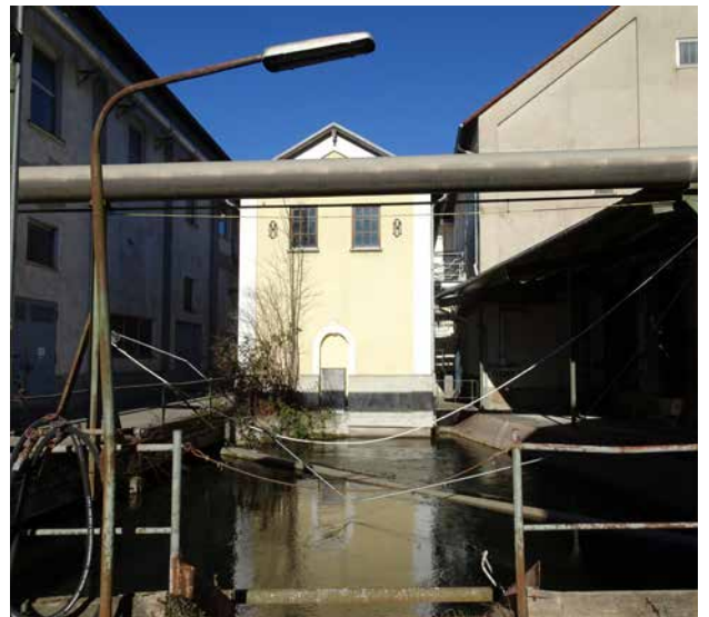
Abb. B.2.3 Dampfmaschinengebäude (Standort 5)
