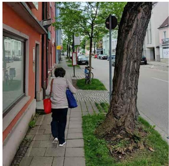
Abbildung 83: Knappe Gehwegbreite auf der südlichen Seite und Schäden durch Wurzelhub.
