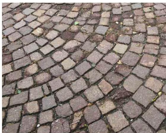
Abbildung 123: Das Segmentbogenpflaster aus frostempfindlichem Porphyrt weist an einigen Stellen Schäden auf
