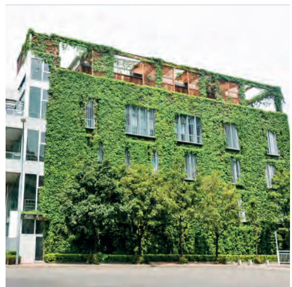
Abbildung 145: Begrünte Fassade eines Wohngebäudes (Quelle: istockphoto.com/Boana )
