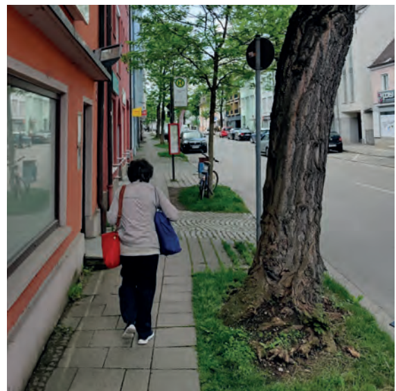
Abbildung 84: Knappe Gehwegbreite auf der südlichen Seite und Schäden durch Wurzelhub.
