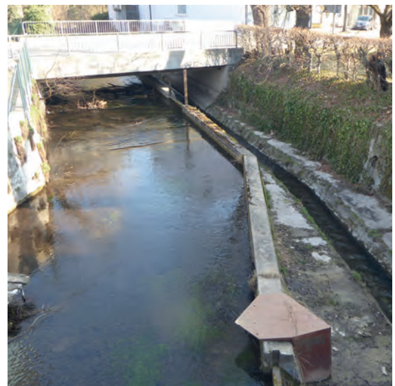
Abbildung 26: Mühl- und Viehgassenbach als Kanal
