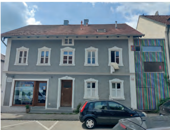
Abbildung 66: Gebäude Steinkirchener Str. 1
