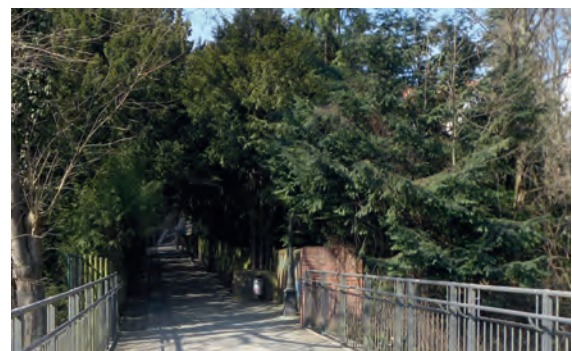
Abbildung 79: Engestelle Reinhold-Grübl-Weg und die bereits tagsüber recht dunkle Martin-Huber-Treppe
