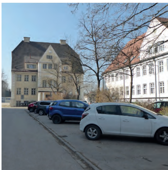
Abbildung 94: Die Freibereiche um die historische Bausubstanz sind ungestaltet.
