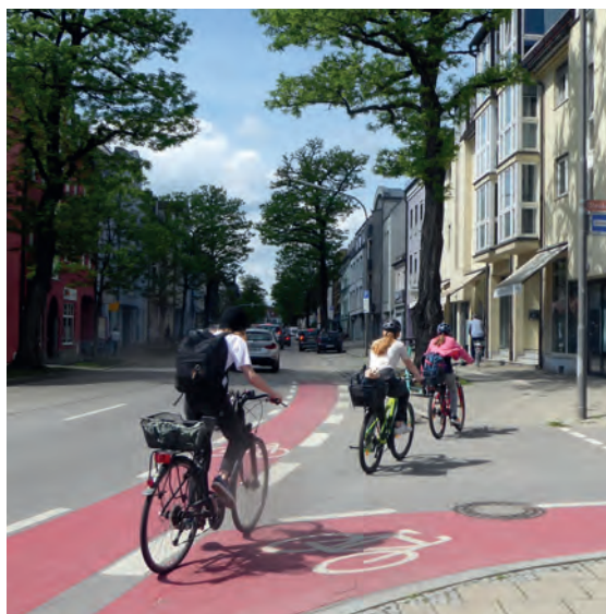
Abbildung 76: Unklare Führung des Radverkehrs: Angebotsstreifen und Führung des Radverkehrs in der Praxis stimmen nicht überein.
