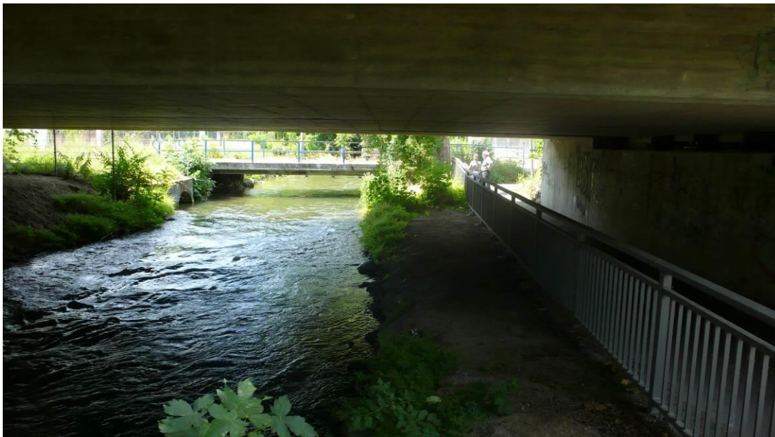
Abbildung 7 Mühlbach im Bereich der Unterquerung der Fernbahn
