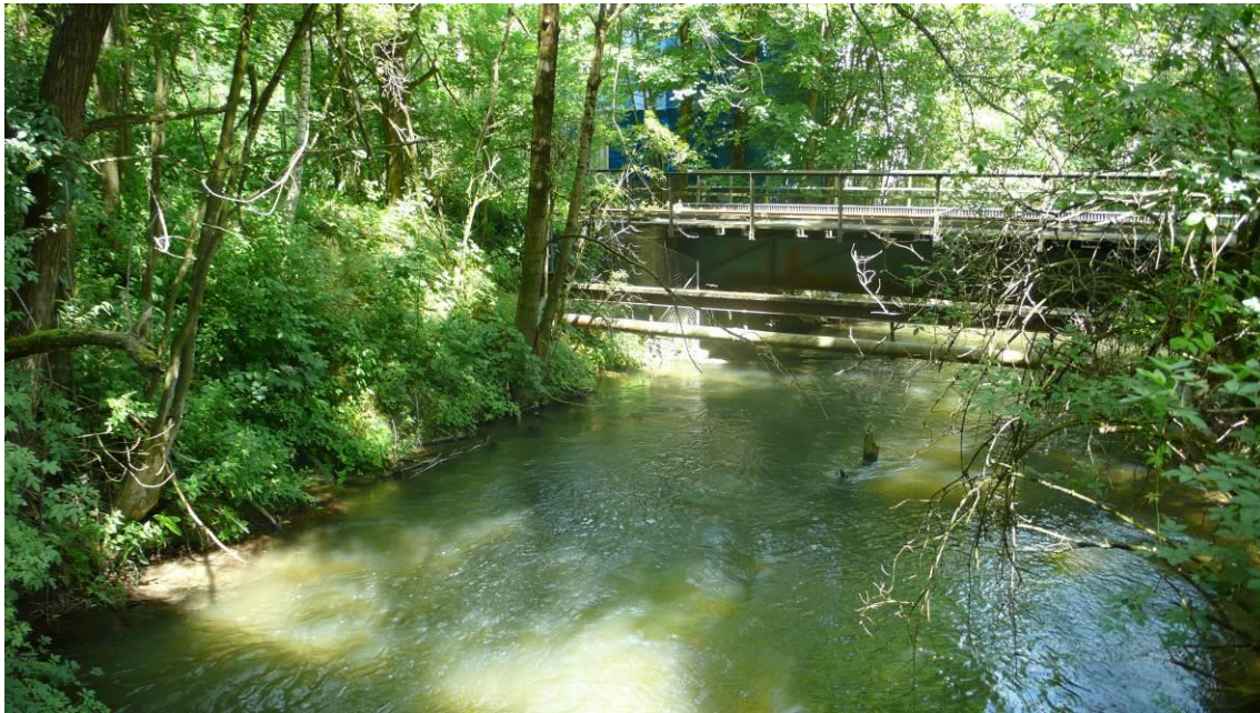
Abbildung 8 Mühlbach im Bereich Unterquerung der Bahnlinie nach Altomünster
