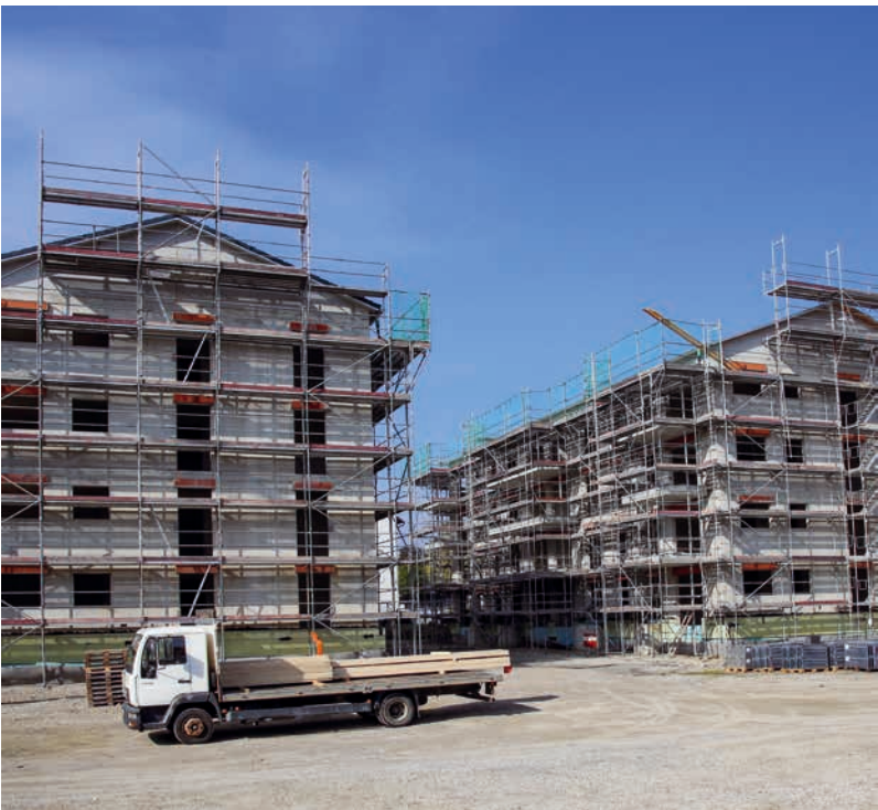
Die Wohnanlage Am Neufeld soll Ende 2027 bezugsfertig sein.
